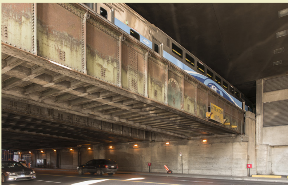
Viaduc ferroviaire Saint-Antoine
