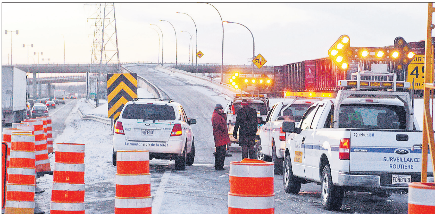
Le viaduc est demeuré fermé toute la journée, perturbant la circulation sur le boulevard des Sources.
