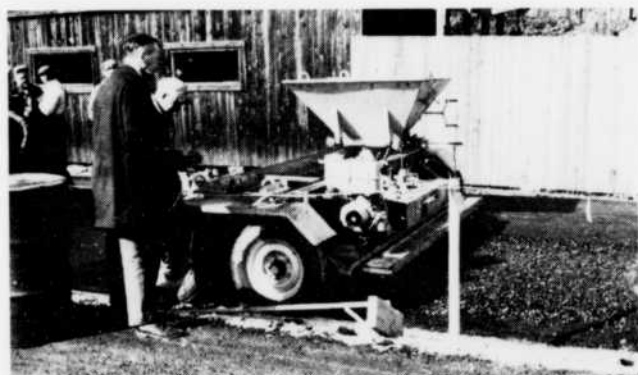
Figure 6 Épandage d'agrégats pré-enrobés sur un mélange bitumineux de type Topeka
