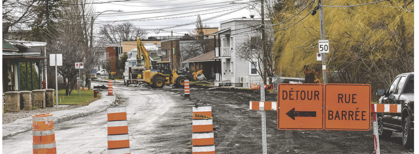
La reconstruction des infrastructures a débuté cette semaine sur l'avenue Saint-Louis à Saint-Hyacinthe, en route pour un chantier qui s'étirera jusqu'à la fin novembre. Photo François Larivière | Le Courrier ©
