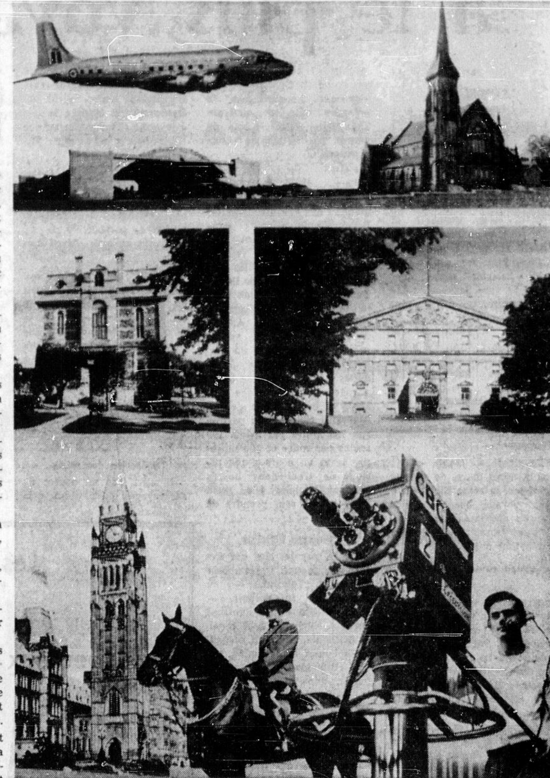
LA VISITE ROYALE — Pendant la visite royale les caméras de télévision de Radio-Canada seront dirigées sur certains points de repère, tels que les édifices du Parlement (en bas, à gauche), l'hôtel de ville de Hull (centre, à gauche), le hangar cantilever de l'ARC
