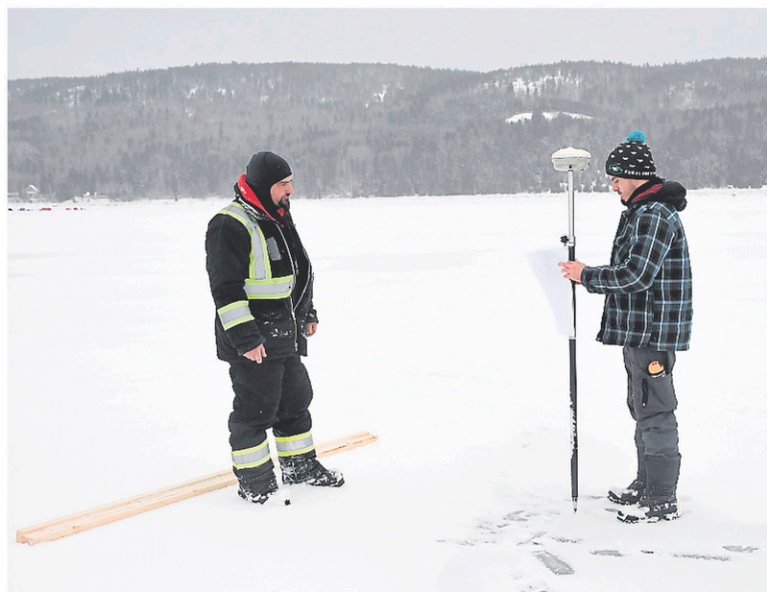
Une douzaine de bénévoles ont pris part aux opérations samedi. Le bornage du site devrait être terminé d'ici lundi. — PHOTO LE QUOTIDIEN, ROCKET LAVOIE
