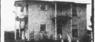
947 rue St-Edouard Plessisville.
