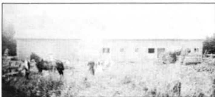
La construction d'une grange, vers 1900 Source : Famille d'Irénée Dubé
