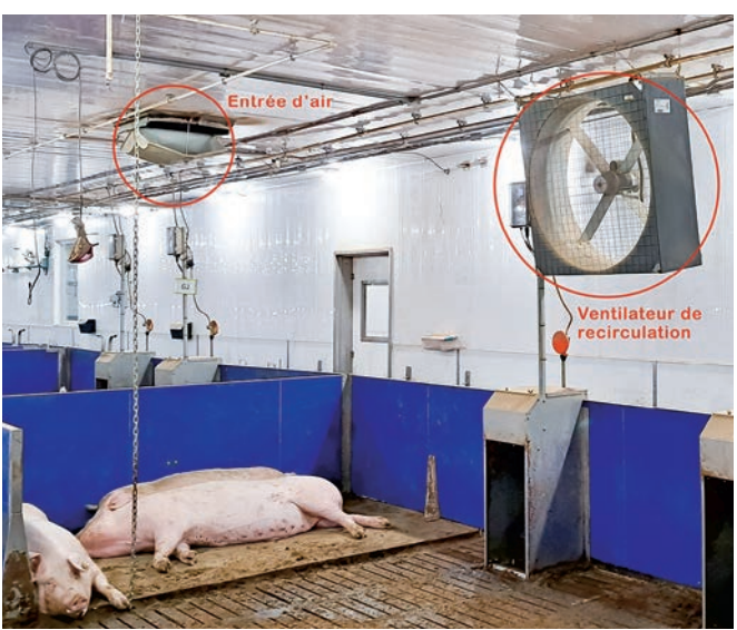
Figure 1. Ventilateur de recirculation et entrée d'air modulaire afin de générer des courants d'air sur les animaux.
