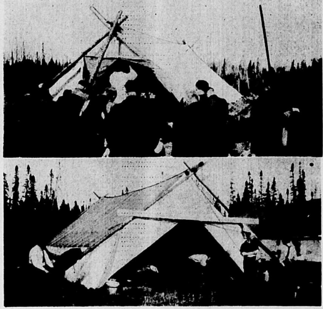
Comme on pourra le constater, nos colons se sont édifiés des abris temporaires, où leur vie est organisée en commun, en attendant qu'ils aient construit des habitations permanentes, avant la venue des froids de l'hiver. De plus, ils sont en relations directes avec le monde civilisé, soit par le réseau routier provincial ou encore le chemin de fer Pacifique Canadien qui dessert cette partie du Québec oriental. Dans la photo du bas, on aperçoit une tente-dortoir où nos colons vont se reposer, après avoir travaillé et peiné toute la journée pour ériger leur demeure, où viennent les rejoindre leurs familles, une fois l'installation complétée. La photo du haut illustre la célébration de la première messe en terre nouvelle. L'officiant, le missionnaire-colonisateur des Trois-Rivières, M. l'abbé Masson lit en ce moment l'Evangile sur l'autel improvisé érigé à l'entrée de la tente. On voit les colons agenouillés derrière l'officiant au moment de l'élevation. (Photo C.P.R.)
