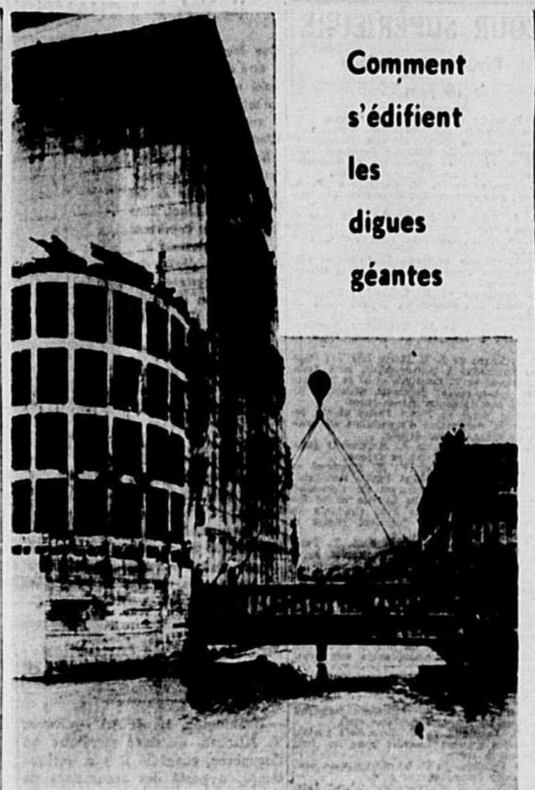
À Clinch River, au Tennessee, les ingénieurs sont à mettre la dernière main à la digue Norris, qui permettra la création d'un lac artificiel de 70 milles de long. On voit ici la mise en état de l'avant-dernière porte d'acier, qui commencera une élévation de cinq pieds dans l'étiage.
