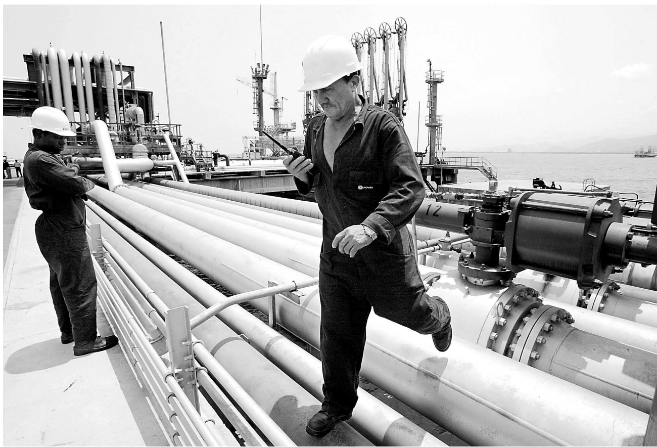
Des employés de la société pétrolière gouvernementale vénézuélienne font l'inspection de pipelines au complexe de la raffinerie d'El Palito, situé à environ 240 km à l'ouest de Caracas, au cours d'une tournée de presse effectuée récemment pour permettre au public de se rendre compte de la bonne marche des activités de l'entreprise d'État.
