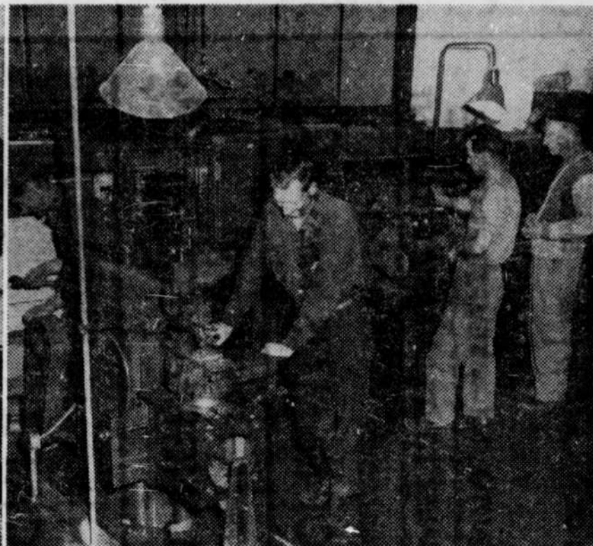
ATELIER MECANIQUE: cette section en est une des plus importantes. Il faut toujours être prêt à réparer toute défectuosité. Au travail, MM. Pierre-Eugène Jean, Robert Delisle, Roland Déry et Ben Girard, maître-mécanicien.
