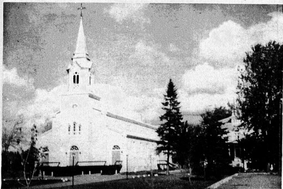
EGLISE DE TOURVILLE — La paroisse de St-Clément de Tourville qui célèbre son cinquantième anniversaire de fondation peut s'enorgueillir d'un magnifique temple dont la rénovation complète s'est terminée en 1968.
