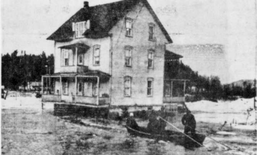
LA QUART DU VILLAGE INONDE — Le lit de la rivière Ste-Anne ne suffisait plus, les eaux ont envahi une importante partie du village de St-Raymond, dans le comté de Portneuf. Cette maison, comme bien d'autres de cette région, a été entourée des eaux provenant de fortes avalées et de la fonte des neiges. Ce phénomène est nettement attribuable aux conditions atmosphériques qui prévalaient dans la province au cours de la fin de semaine de Noël. (Téléphoto PC)
