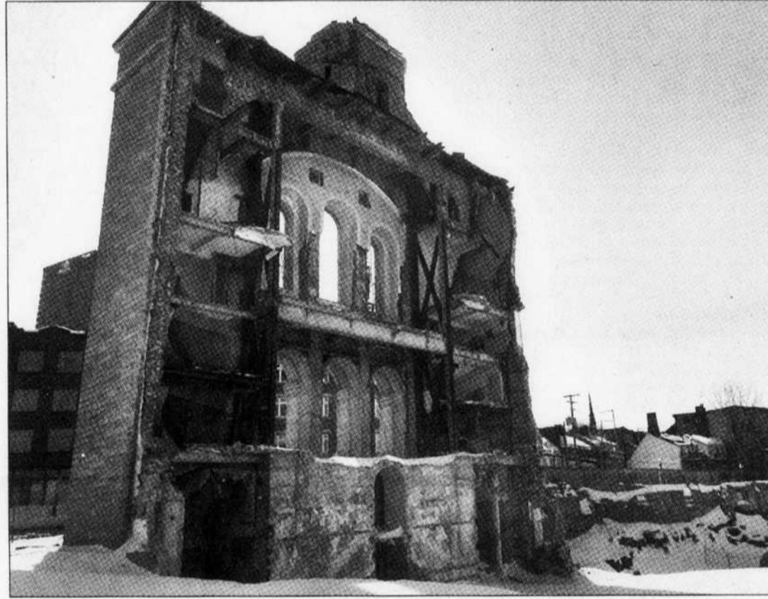
La façade de l'église Saint-Vincent-de-Paul, à Québec.
