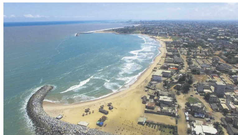
Protection des berges à Cotonou, au Bénin, un projet de Norda Stelo.
