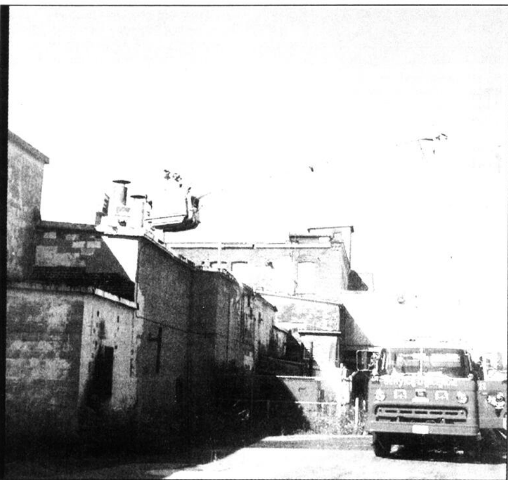
Bien que l'édifice n'ait pas été complètement détruit, les dégâts matériels sont de tout de même considérables. (photo P.L.)
