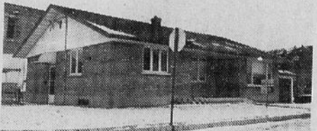
VALLEYFIELD tout brique avec garage, 4 c.c. $75,000.
