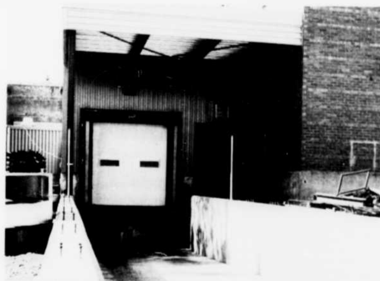
La rampe de réception et d'expédition du nouveau magasin d'Énergie électrique Québec, à Isle-Maligne. (Photo Jean Matteau)
