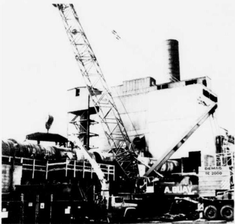
La plus grosse grue à l'oeuvre sur le territoire du Québec... 440 tonnes de chargement... Un vrai mastodonte!
