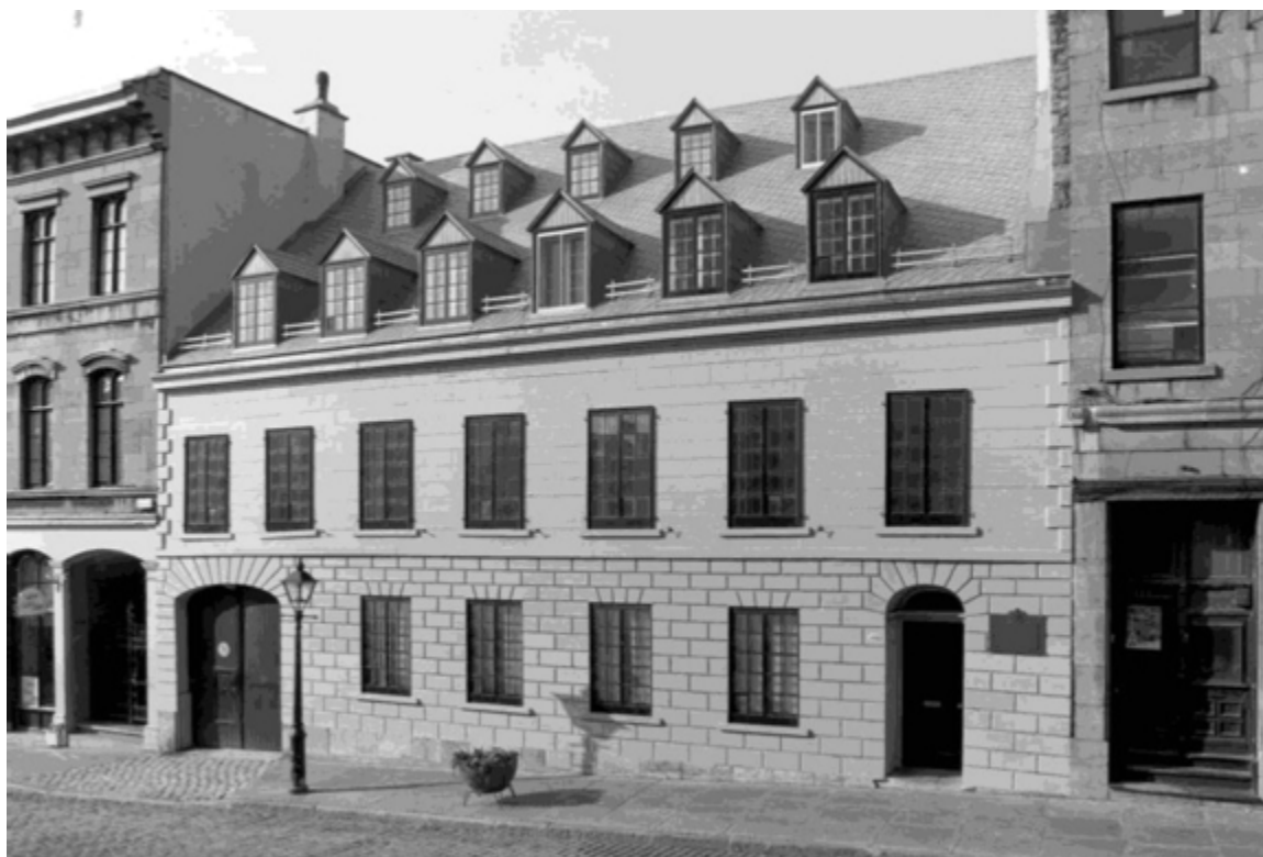
Maison Papineau après les travaux de restauration, 1978 (Parcs Canada, fonds McLean, photographe : Eric McLean)
