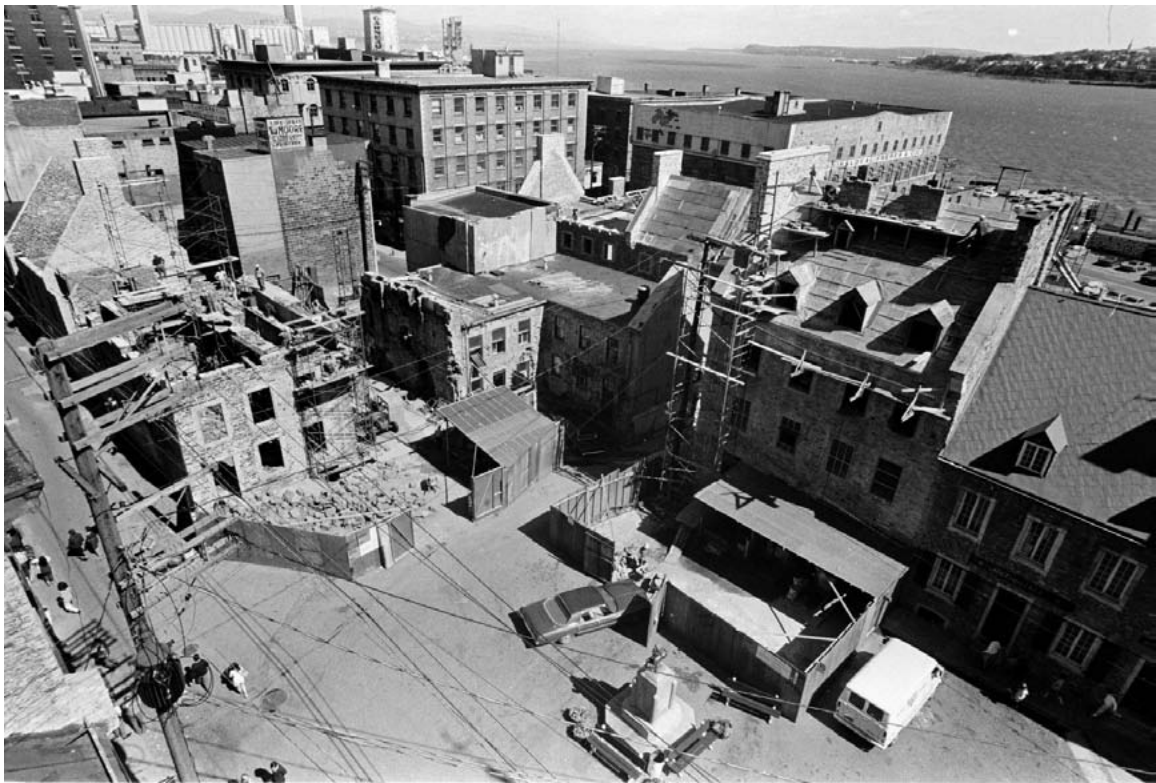
Vue aérienne du chantier de Place-Royale, devant le parvis de l'église de Notre-Dame-des-Victoires, 1971 (BAnQ, photographe : Jules Rochon, E10,S44,SS1,D71-327)
