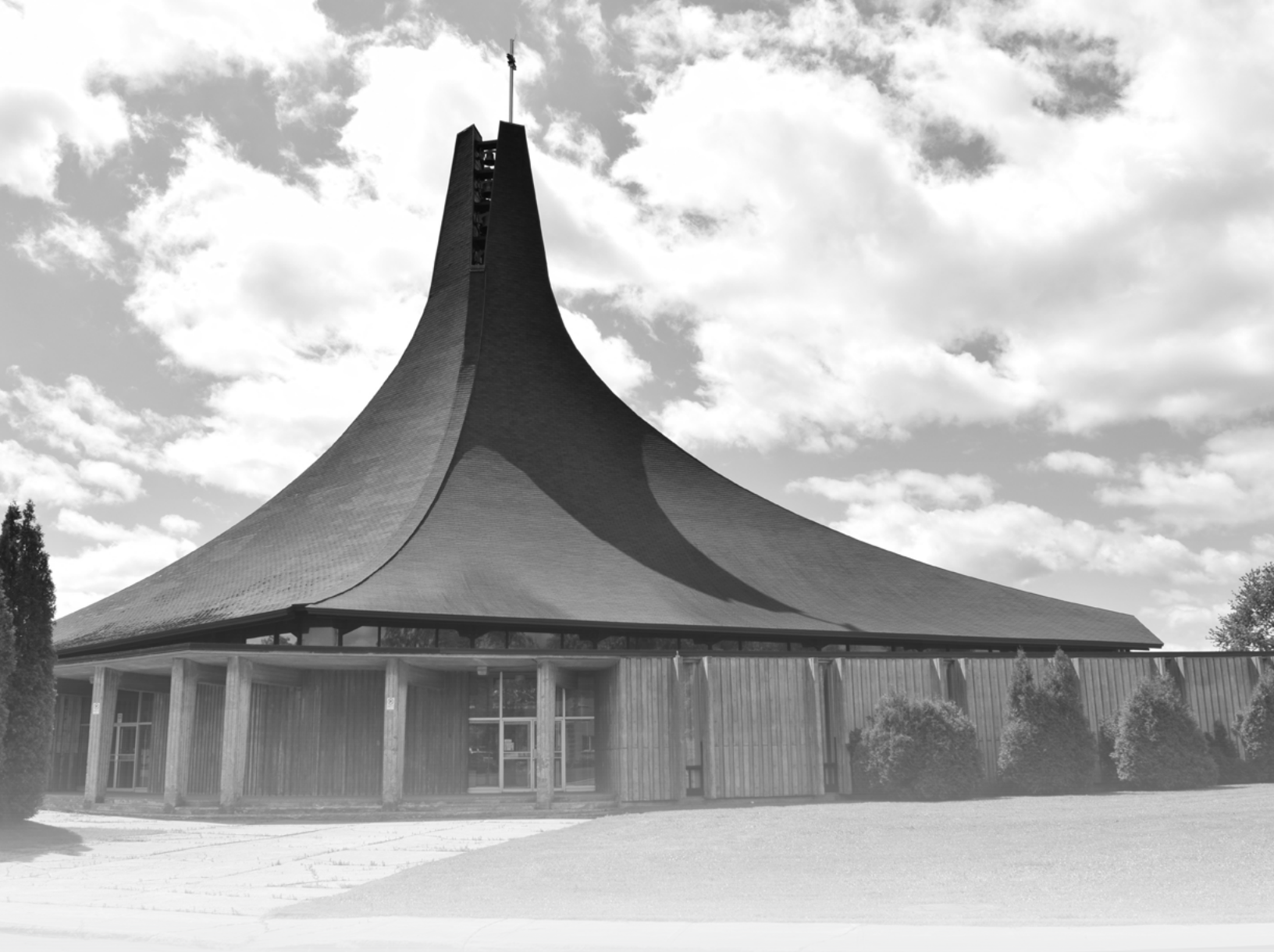
Église Saint-Mathias (1964-1965; architecte : Jacques Coutu), située dans le secteur Arvida à Saguenay et classée en 2021
