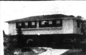
Rue Potvin, résidence pour professionnel. 47.5 x 44. Terrain 11,560 p.c.
