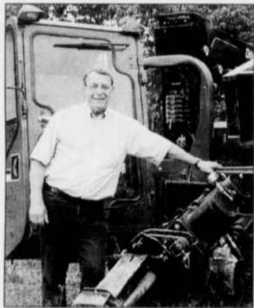
Bernard Généreux était heureux de montrer qu'enfin les travaux de creusage pour le nouveau puits d'eau potable étaient commencés.
