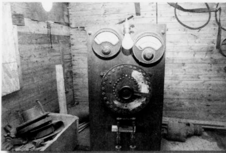
Cet équipement servait à distribuer l'électricité dans le village.
