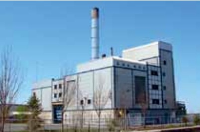
L'usine Gazmont capte le méthane produit par les matières organiques en décomposition enfouies dans l'ancien dépotoir à travers 375 puits de captage et le transforme en électricité.
