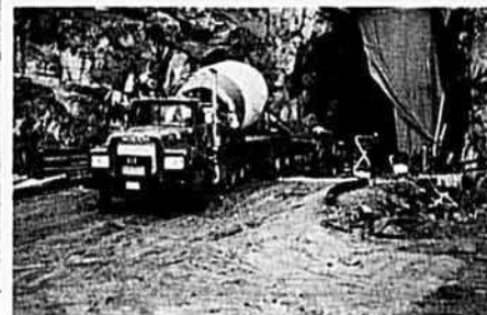
Un camion-malaxeur de Francon livrant du béton sur le chantier LG 3
