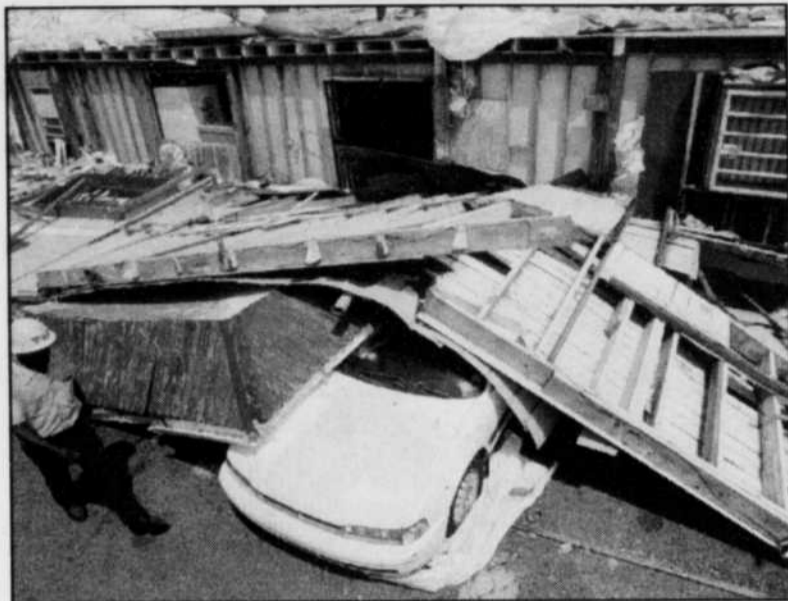
L'île de St-Thomas a vu Bertha de près. La façade d'un commerce s'est effondrée sur cette voiture. Le même édifice avait perdu sa toiture lors du passage de Marilyn, un autre ouragan dévastateur, l'an dernier.
