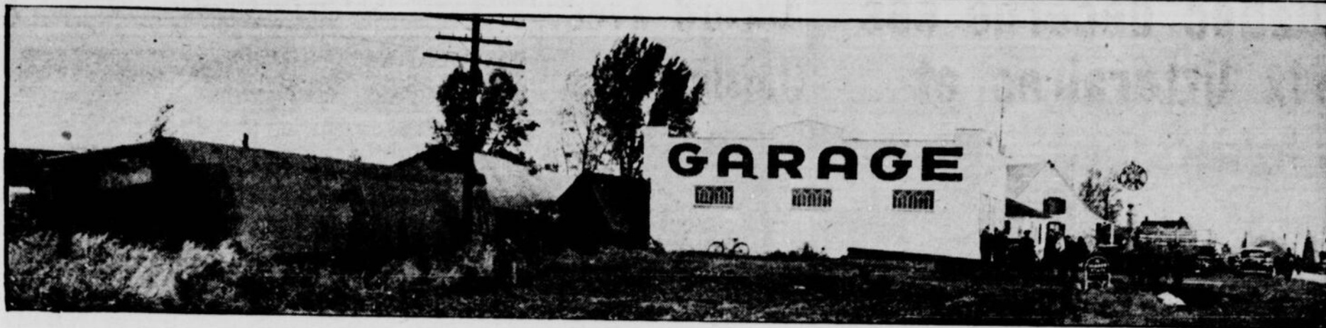
Le garage de M. Aimé Lemire dont le hangar a été enfoncé par un des wagons renversés. (Photo la "Patrie").
