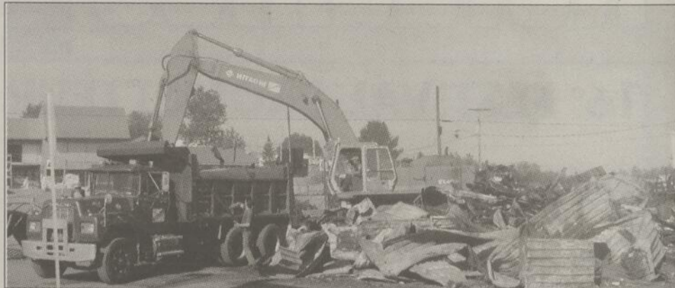
La firme Excavation Normand Majeau a procédé, la semaine dernière, au nettoyage du site de la quincaillerie Piette, incendiée, il y a quelques semaines, afin qu'on puisse reconstruire un nouveau magasin moderne. Photo Jean-Guy Pinel
