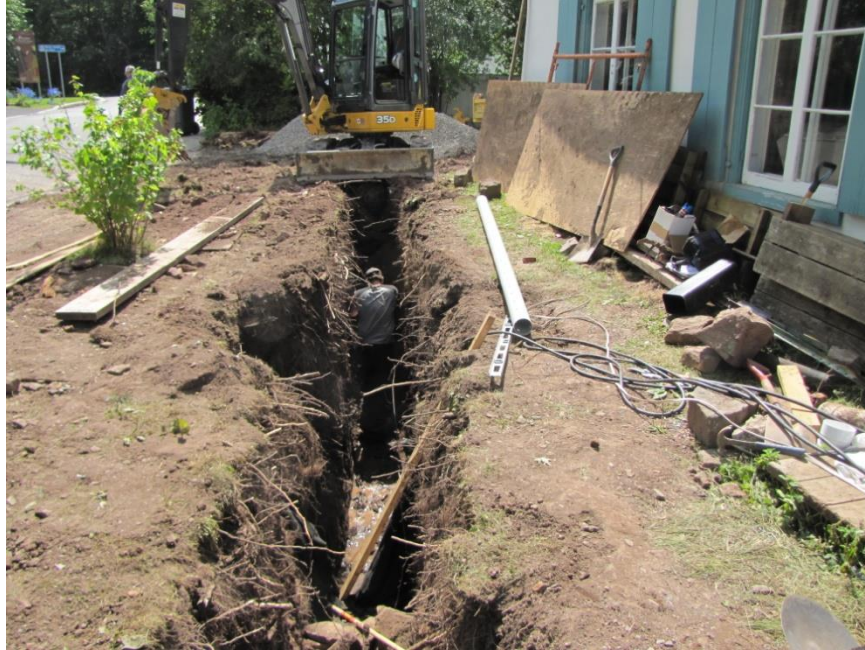
Figure 1. Vue de la tranchée d'excavation devant la maison. En direction ouest, photo Serge Rouleau, A12-04-35.
