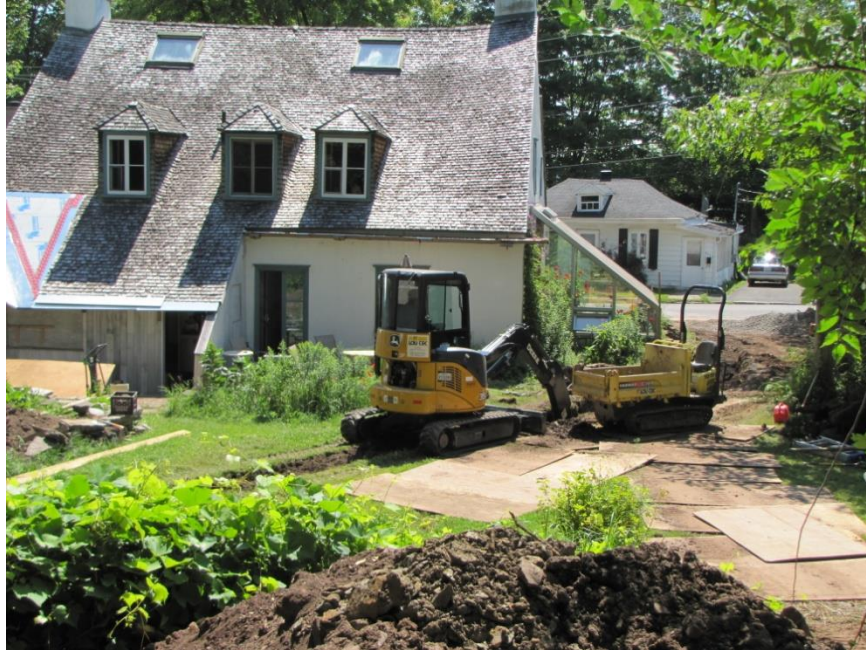
Figure 3. Vue de la tranchée dans la cour arrière. En direction sud, photo Serge Rouleau, A12-05-17.
