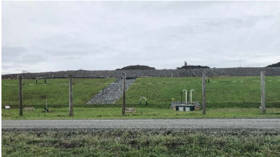
FIGURE 4 EXEMPLE D'UNE DESCENTE PLUVIALE
