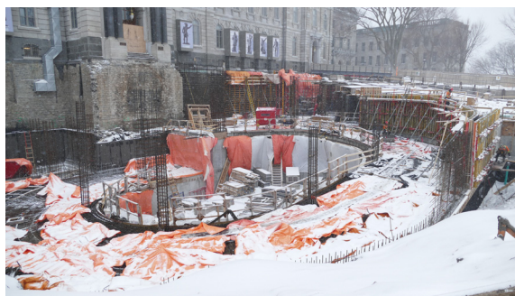
Fondations Mai 2016 à décembre 2017
