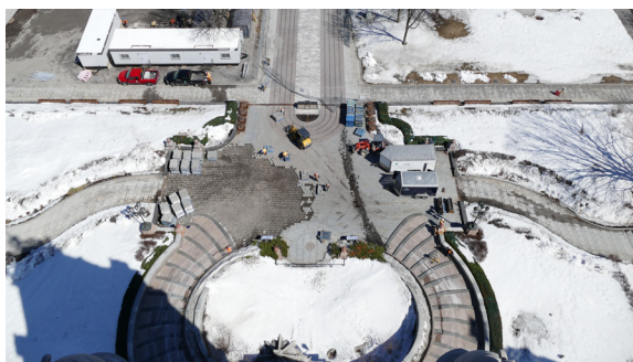
Début des travaux Mars 2016
