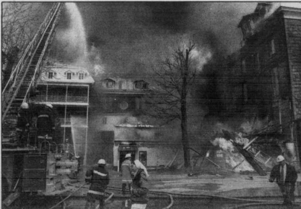
Sur le côté du bâtiment centenaire, où l'incendie a débuté, un mur s'écroule.
