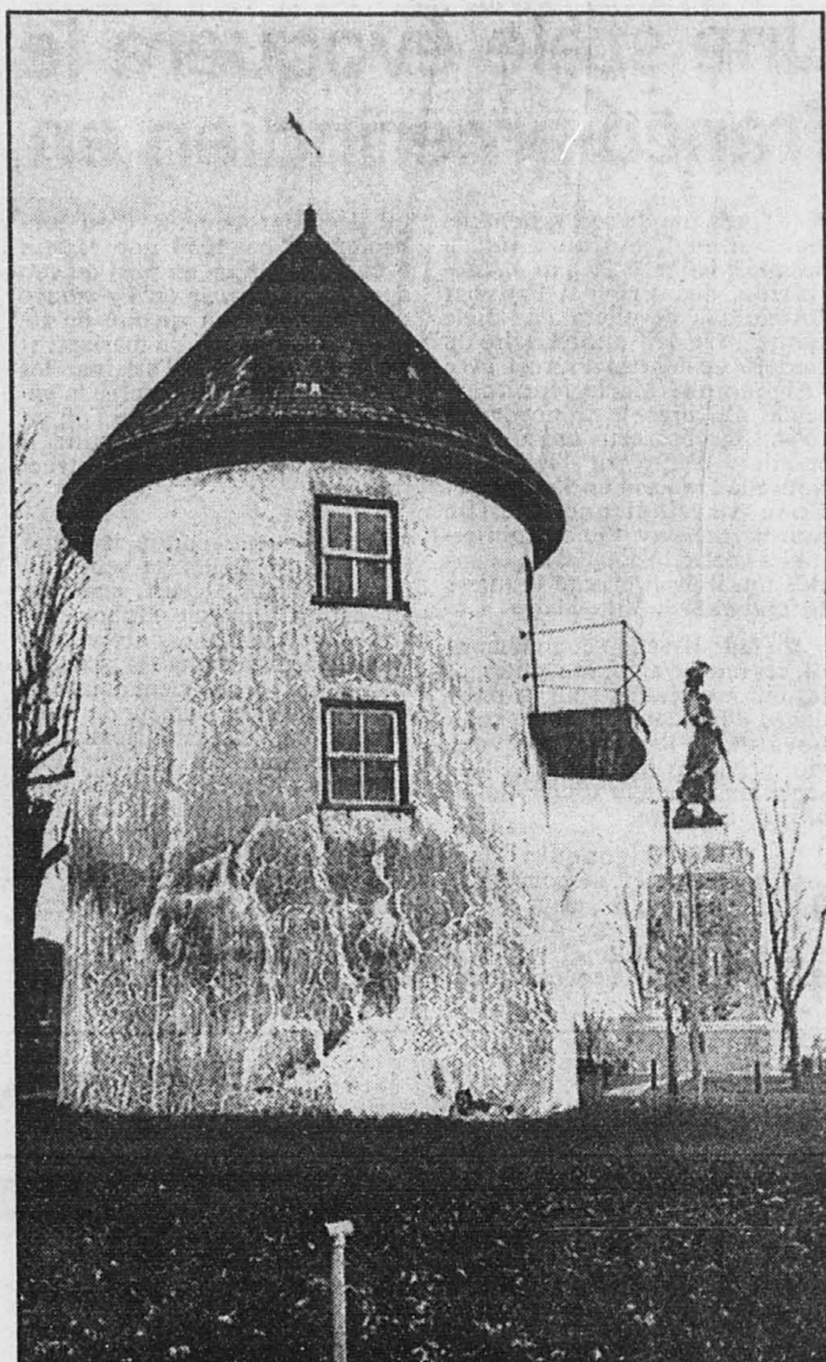
De l'ancien moulin bâti vers 1730, il ne reste qu'une tour de maçonnerie crépée et recouverte d'un toit conique.
