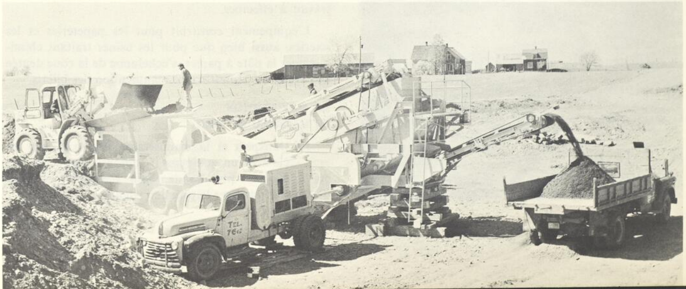
Station de concassage mobile en marche.
