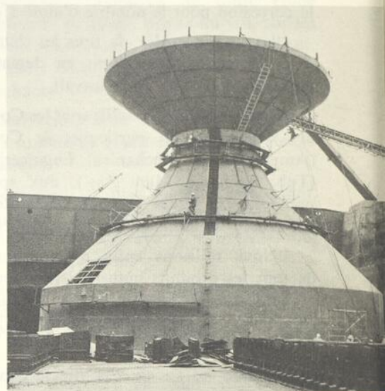
Chantier du caisson du phare, réalisé par Louis Donolo Inc. et Janin Construction Ltd.
