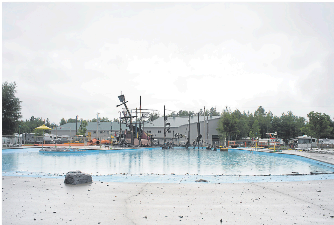
En l'espace de 90 minutes, le bateau-pirate, la glissade et jeux d'eau du camping Otamac ont été ravagés par les flammes. La piscine n'a pas été touchée mais elle nécessitera un grand nettoyage. — PHOTO: SYLVAIN MAYER
