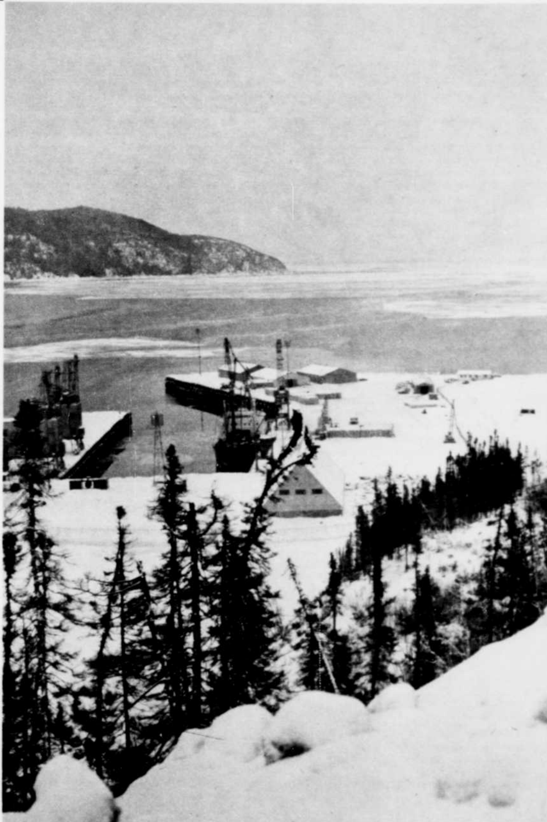
Le Helga Dan , amarré à ce quai de Baie-Comeau, est venu chercher 2,500 tonnes de lingots d'aluminium.
