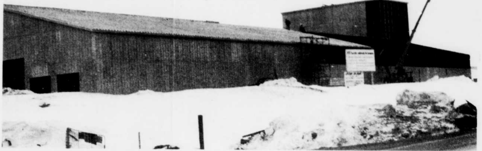
Dans le cas de FusoRoc, la recherche de partenaires privés serait presque terminée. Cette photo avait été prise en février 1984 alors que les travaux d'aménagement étaient encore en cours.
