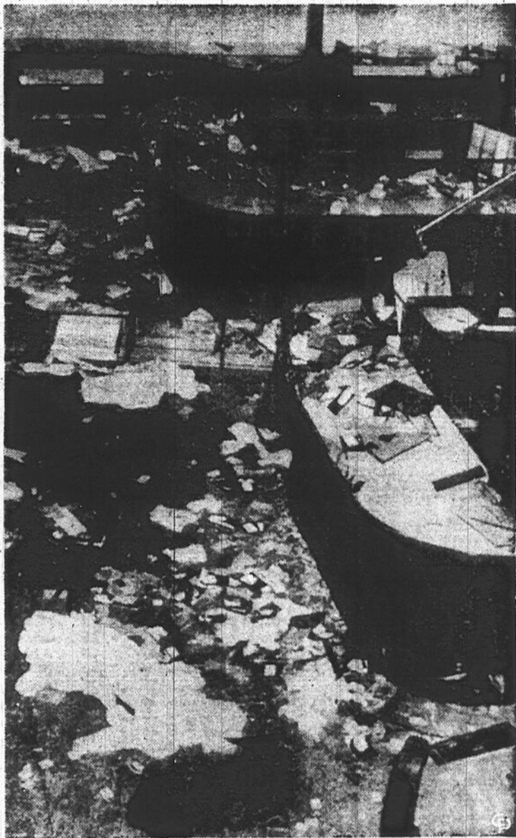
Des dégâts se chiffrent par plus de $5,000,000 furent causés au cours des manifestations de la Victoire, à Halifax. Presque tous les magasins du quartier commercial furent détruits. Voici sur cette photo ce qui reste d'une bijouterie des plus modernes.
