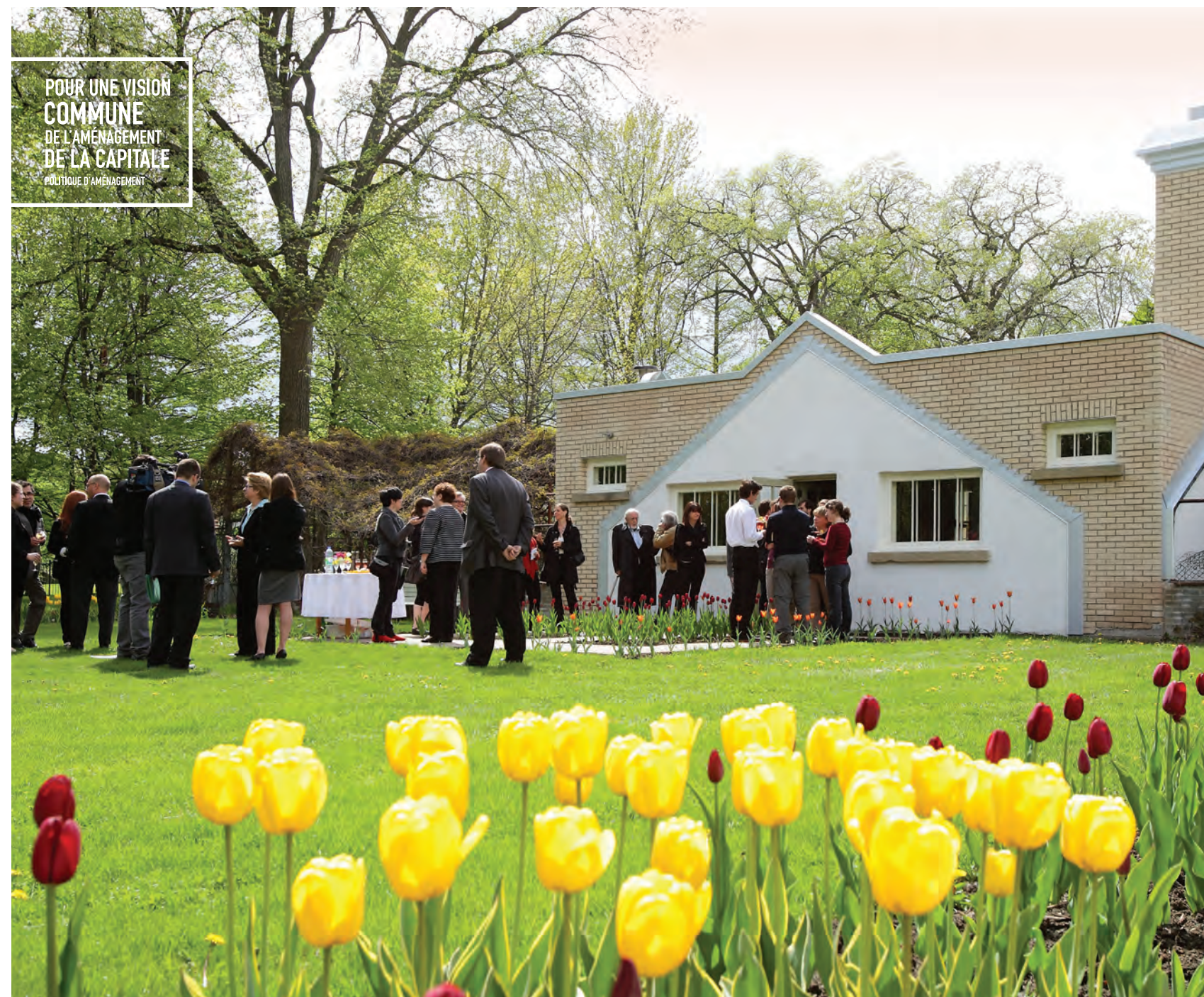
La chaufferie des anciennes serres du parc du Bois-de-Coulonge en 1998 et en 2013 après sa restauration en centre d'interprétation.
