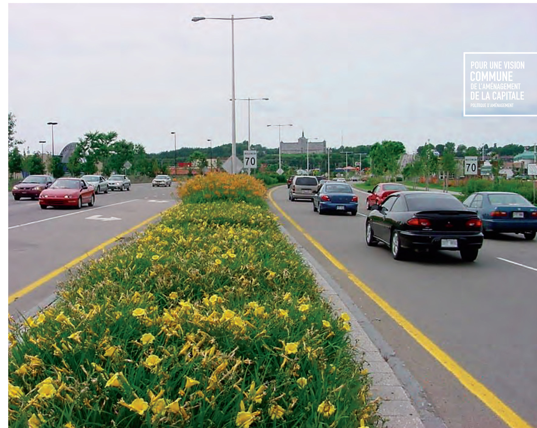
Une portion de l'autoroute Duplessis a été requalifiée en boulevard urbain grâce à la construction de trottoirs, de passages pour piétons, la mise en place de mobilier urbain et la création d'un couvert végétal continu.
