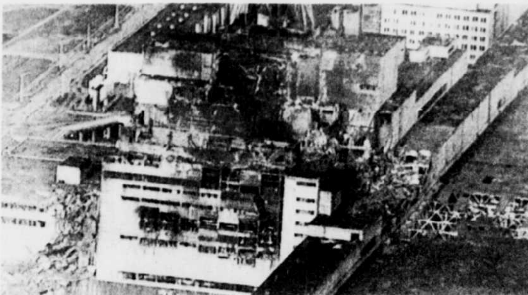
Les dommages causés à la centrale de Tchernobyl sont très visibles sur cette photo publiée par l'agence Tass.
