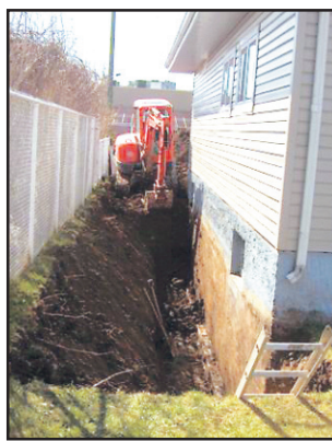
Les tranchées peuvent être réalisées dans les endroits les plus étroits.
