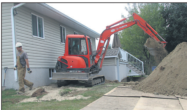
Les matériaux excavés sont déposés sur des panneaux de contreplaqué afin de ne pas abîmer l'aménagement existant.
