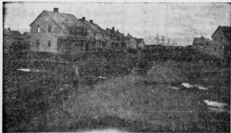
Arvida ne représentait qu'une poignée de maisons, lorsque la Banque de Montréal ouvrit sa succursale dans notre ville. Cette photographie, vieille de trente ans, fait voir les travaux de construction qui se poursuivaient pour loger la population rapidement grandissante.
