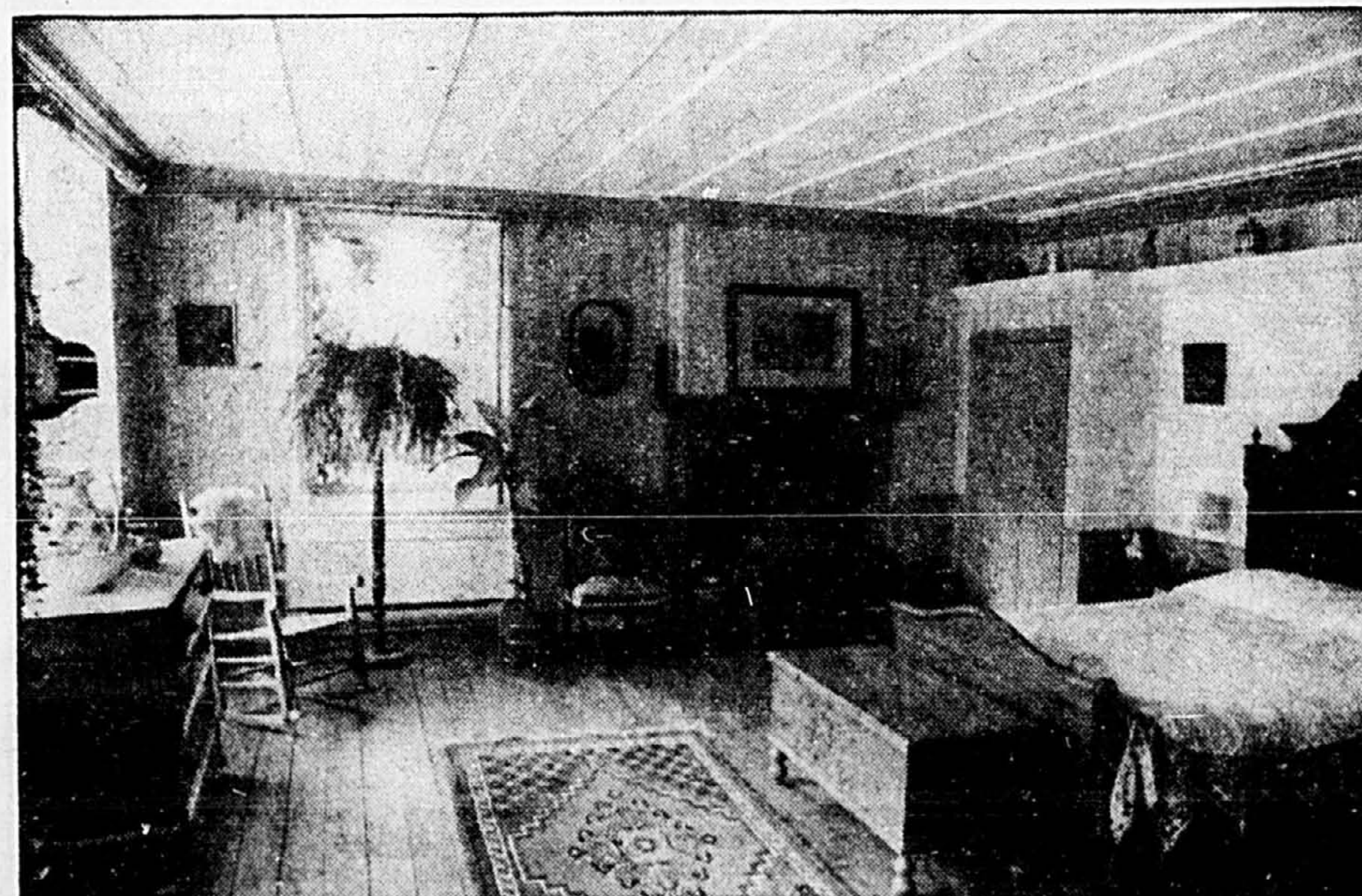
Une des nombreuses chambres à coucher. Les plafonds en caisson recouvrent les dizaines de poutres installées lors de la construction.
