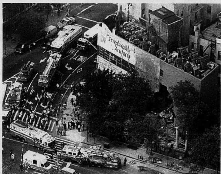
Plusieurs camions à incendie et des unités de situations d'urgence sont sur les lieux d'un effondrement partiel d'un édifice commercial de quatre étages à New York. L'effondrement se serait produit à la suite d'une explosion après une fuite de gaz.
