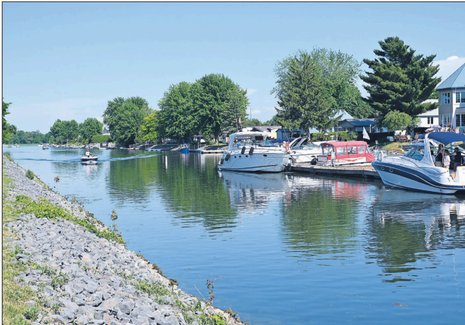
Le coût du dragage de l'ensemble des canaux est estimé entre 5 et 8 M$. Ils n'ont jamais fait l'objet d'un entretien depuis leur aménagement, à partir de 1955.
