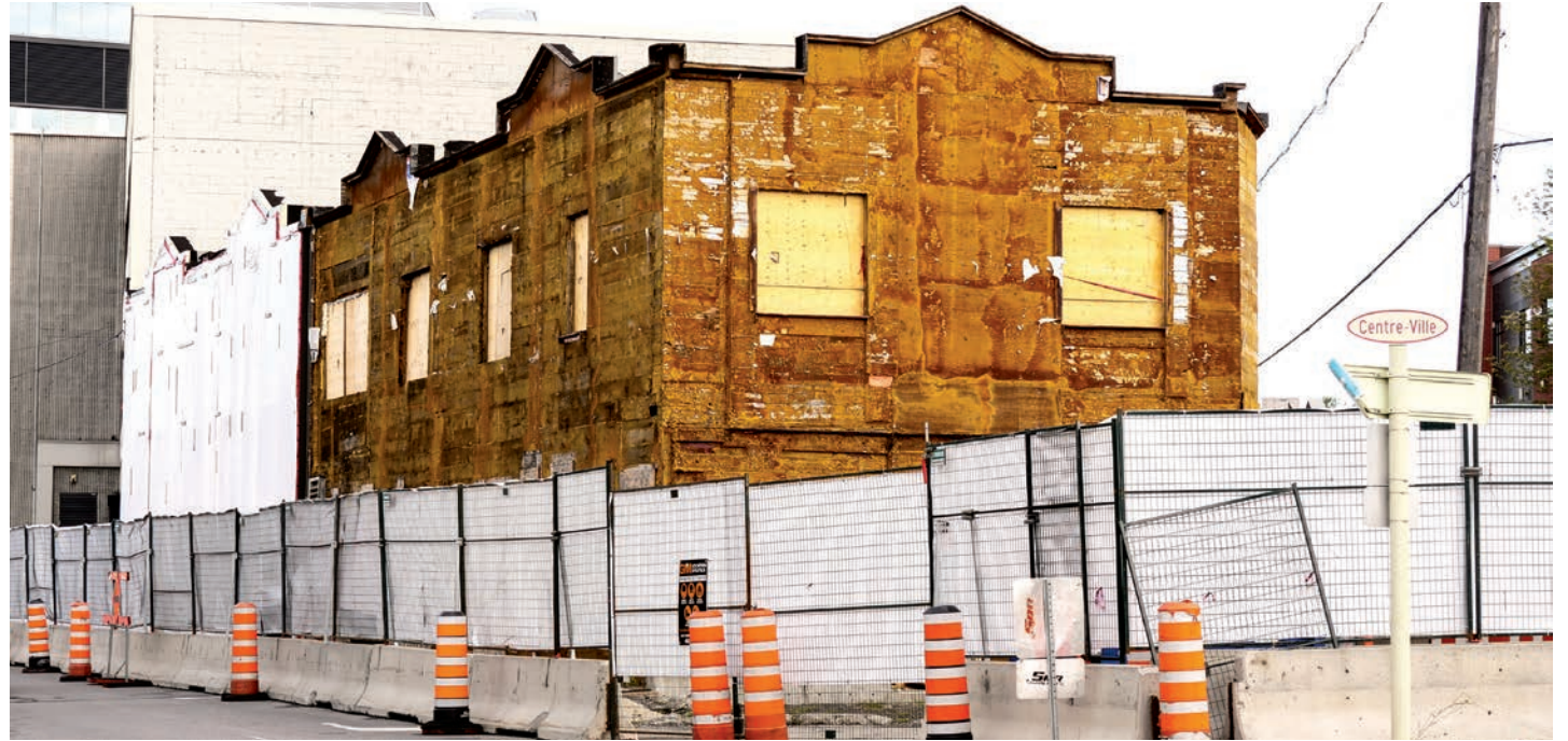
Crédit : Courtoisie Ville de Saint-Jérôme L'ancien édifice Taillon en août 2023 avant sa démolition.
