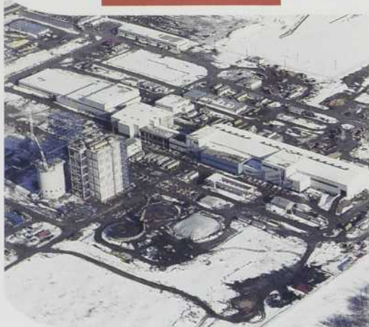
NORSK HYDRO Bécancour
