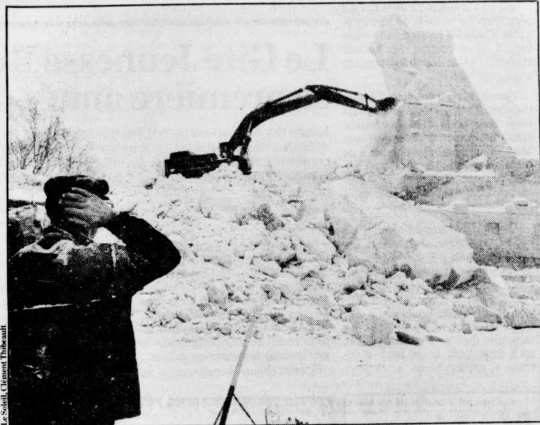
M. Gaston Fortier qui a travaillé chaque année depuis 32 ans à la construction du palais de neige du Bonhomme Carnaval regardait hier avec une certaine mélancolie une pelle mécanique qui s'affairait à démolir l'un des symboles de cette fête hivernale. « Dire qu'on est en train de démolir en quatre heures ce qui nous a pris 4000 heures à construire », a affirmé M. Fortier. La construction du palais a coûté environ 100 000 $.
