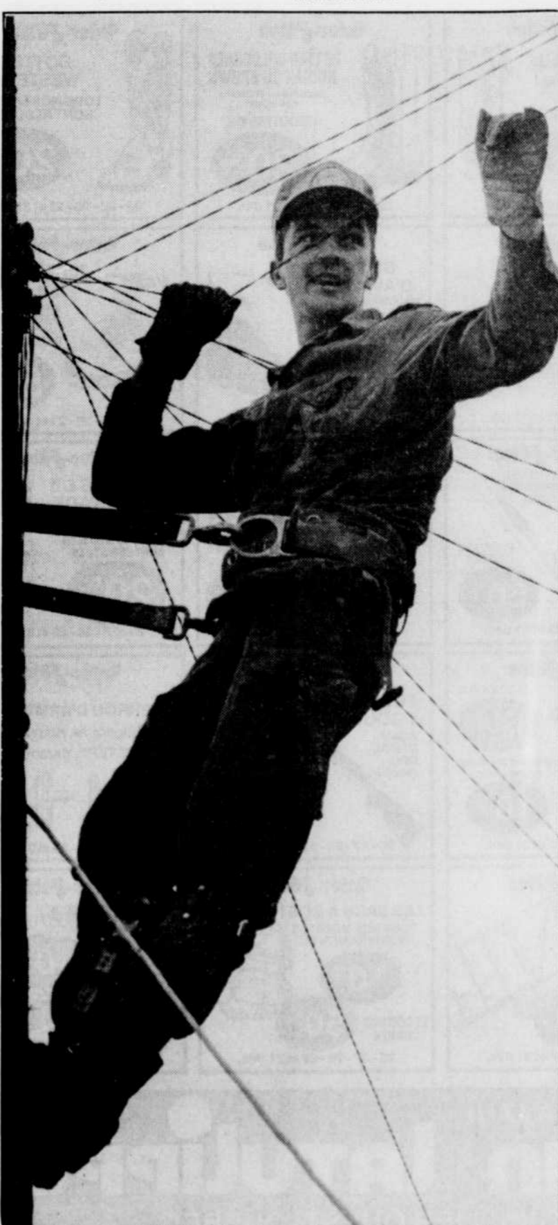
Le caporal Régis Pilote de la base de Valcartier, à Québec, attaché au 5e Bataillon de Service du Canada vérifie la tension des lignes téléphoniques du Camp Pollom, en Croatie. Ce camp de l'ex-armée Yougoslave a été assiégé l'année dernière lors des combats entre Serbes et Croates.
