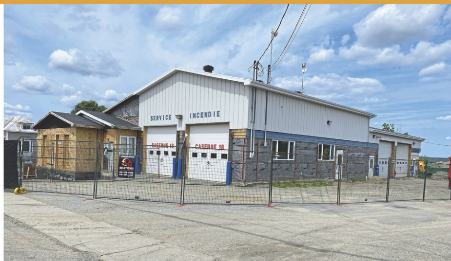
Le complexe municipal de Saint-Philémon subit actuellement une cure de rajeunissement, des travaux d'agrandissement et de mise aux normes étant en cours depuis le début du mois de juin. (Photo La Voix du Sud – Serge Lamontagne)
