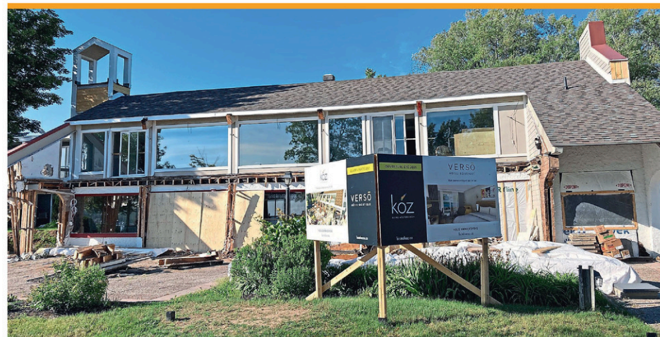
Des travaux majeurs sont actuellement en cours à l'Étoile-sur-le-Lac, qui prévoit une réouverture à l'été 2021. (Photo Le Reffet du Lac - Dany Jacques)
